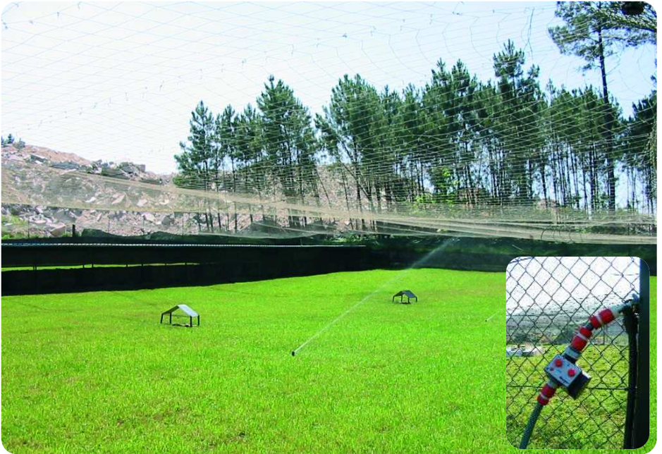
Sistema de riego para mantener en buen estado la pradera. A la derecha: Detalle control de riego.
