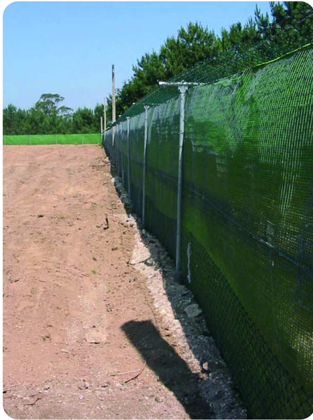
Valla finalizada con parte superior en forma de T
